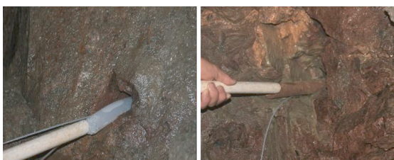
图 4 水封爆破现场装填
